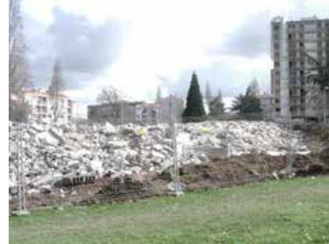
2004 : Démolition « Laurent Bonnevey ».
