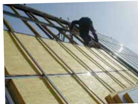
2005 : Capteurs solaires pour la production d'eau chaude sanitaire collective.
