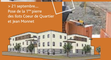
Ilot Jean Monnet 12 logements
