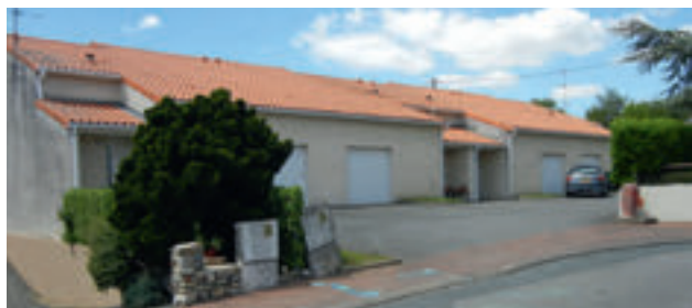
Pavillon de type 3 - 75 m 2 à étage 17 rue des Roses 75 000 € (hors frais de Notaire)
